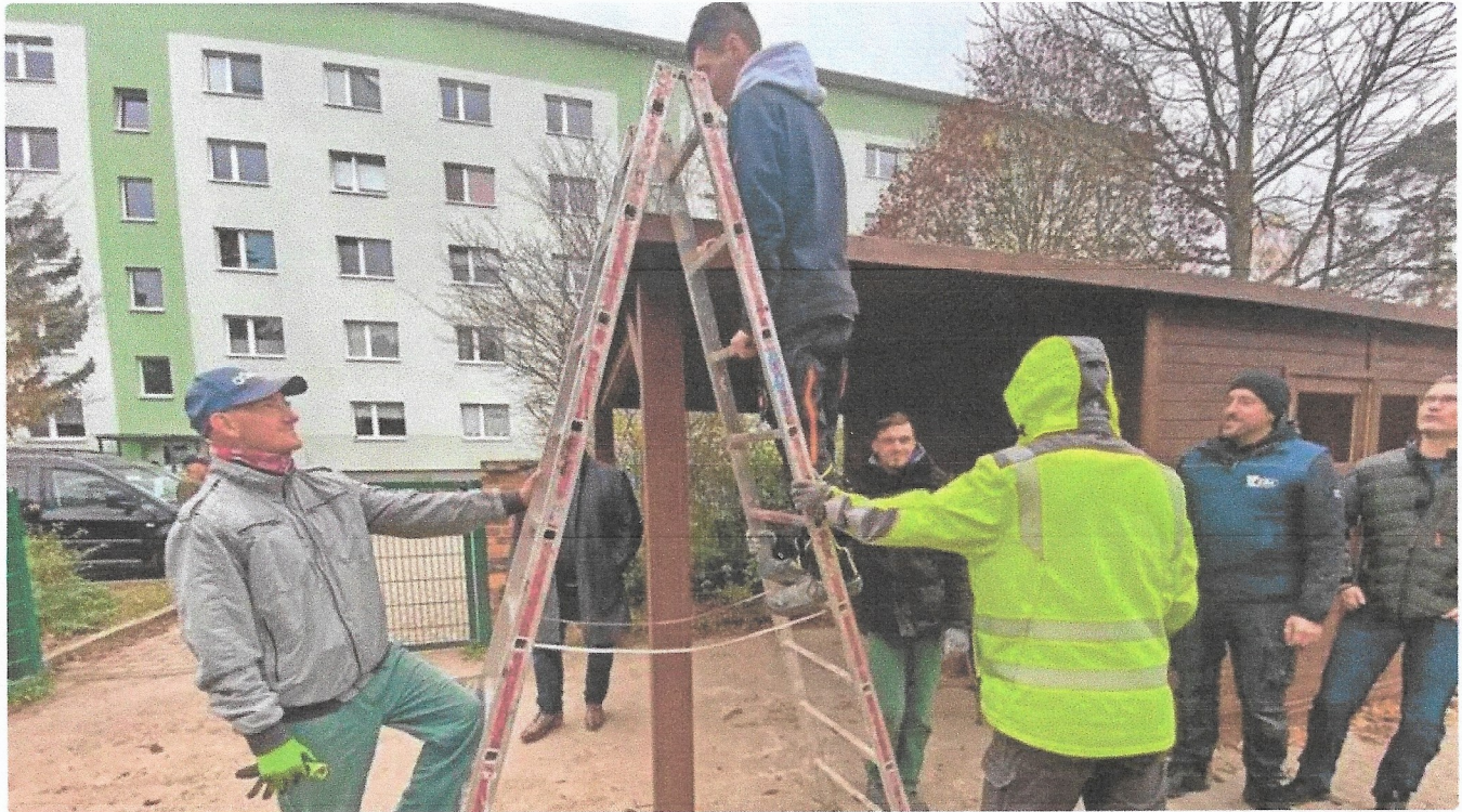
ZAL-Auszubildende bei letzten Arbeiten am Schleppdach.
